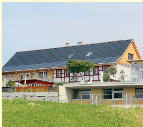
Bauernhaus mit Solardach in Strohwillen
