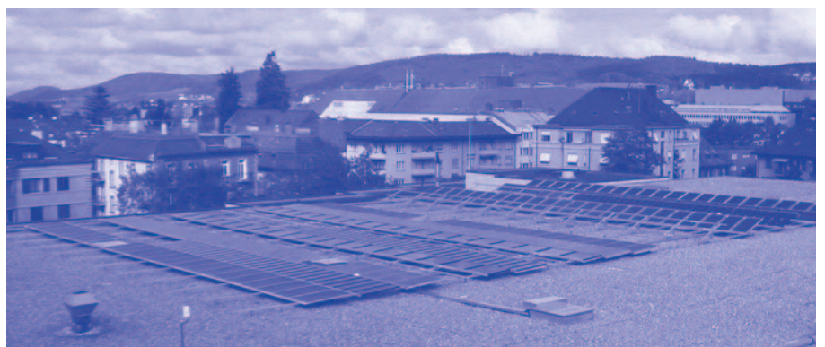
Ein vom Bundesamt für Energie unterstütztes Forschungsprojekt untersucht die Eigenschaften von sechs verschiedenen Dünnschichtzellen. Foto: Energiebüro, Zürich
