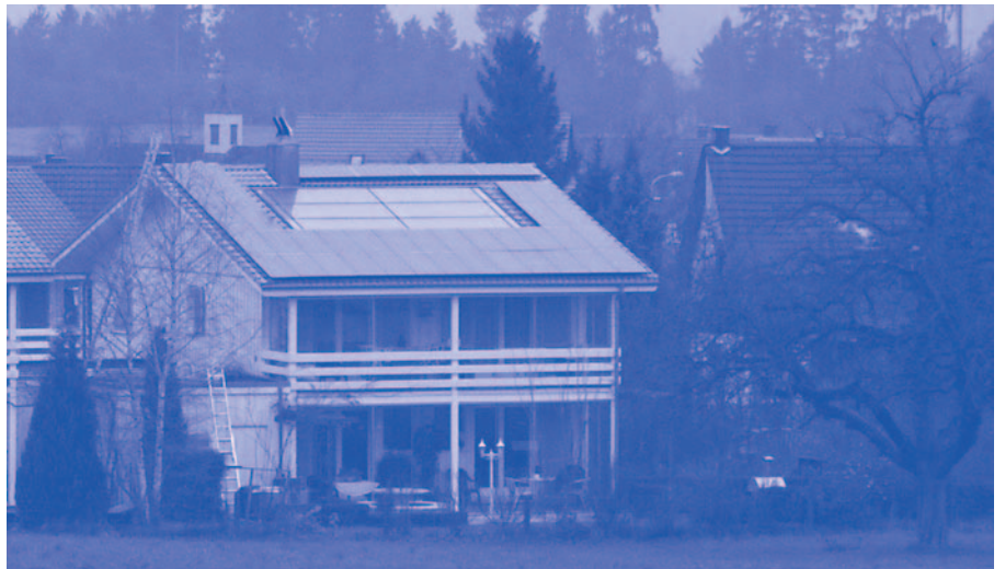
5 kW-Solarstromanlage in Wittenwil. Mit Unterstützung des Solarstrom-Pools Thurgau und des Kantons Thurgau realisiert.
